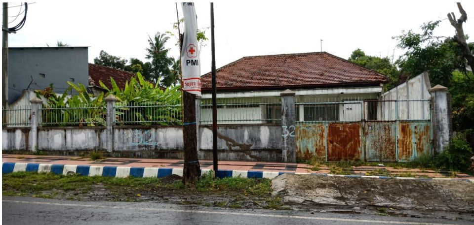
Gambar 1.4 Tapak Eksisting dari Sisi Selatan
