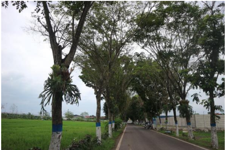
Gambar 3.6 Kondisi Jalan Lokasi IPLT
