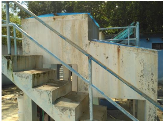
Kondisi Bangunan Penangkap Mata Air Senjoyo
