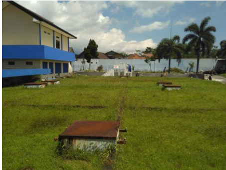
Kondisi Bangunan Ground Reservoir Ngaglik
