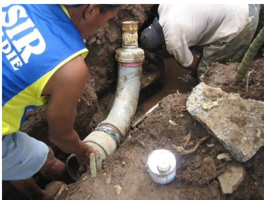
Kondisi Saat Perbaikan Perpipaan
