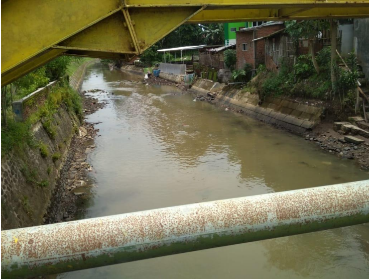
Gambar 2. 6 Kondisi Fisik Sungai Amprong (b)
