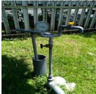
Gambar 5. 7 Alat Manometer yang Terpasang pada Inlet Jaringan
