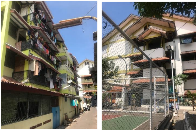
Gambar IV. 1 Kondisi Rusunawa Sombo
