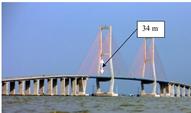
Gambar 4.4 Jarak Jembatan Suramadu Terhadap Air Tertinggi
