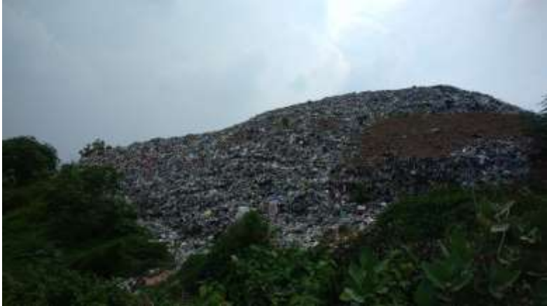
Gambar 5.2 Dokumentasi timbunan sampah yang tidak tertutup oleh cover soil
