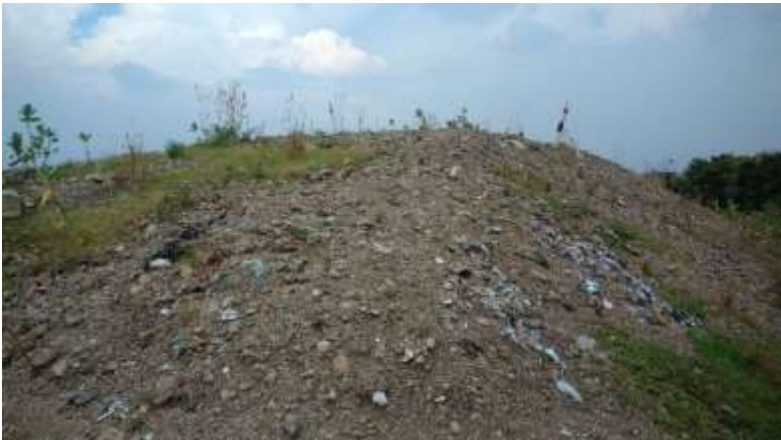
Gambar 5.3 Dokumentasi timbunan sampah yang tertutup oleh cover soil
