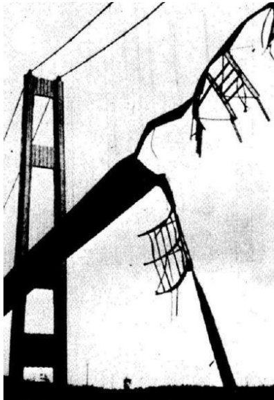
Gambar 2. 28 Keruntuhan jembatan Tacoma (Soegihardjo, 2007).
