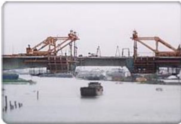
Gambar 4. 49 Form traveler yang digunakan
