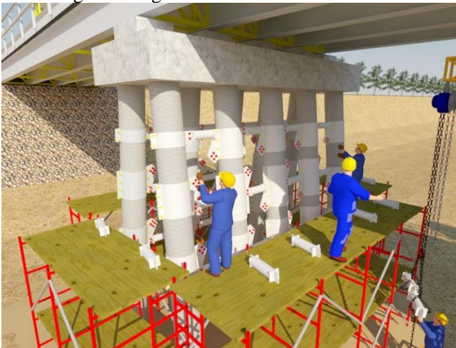
Gambar 5. 17 Pemasangan batang horizontal
