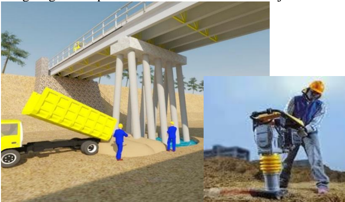
Gambar 5. 13 Pengurugan dan pemadatan tanah untuk area kerja
