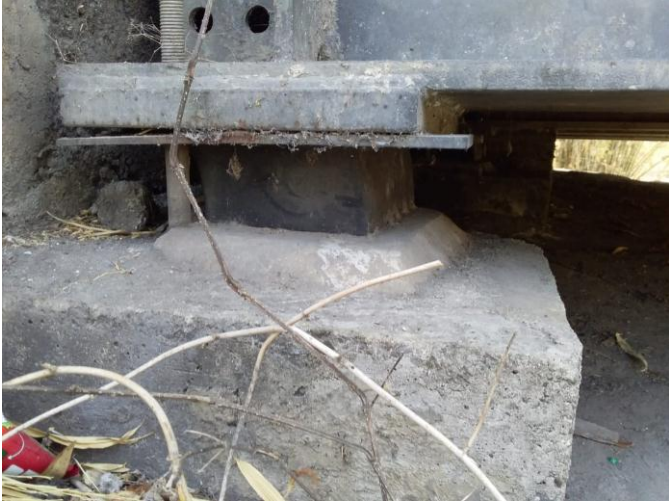
Gambar 1. 11 Perletakan Bearing Pad
