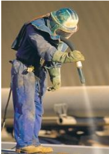
Gambar 5. 11 Pengecatan Anti Korosi
