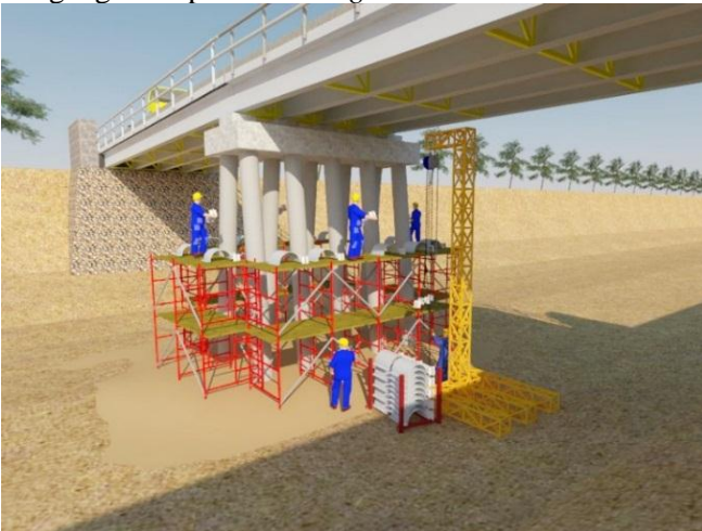
Gambar 5. 15 Pengangkatan profil bracing
