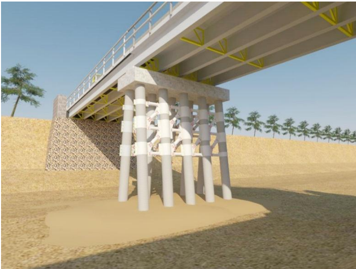
Gambar 1. 5 Rencana Perkuatan Bracing
