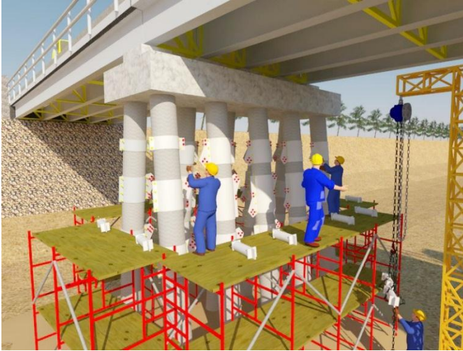
Gambar 5. 16 Pemasangan klem baja ke dua sisi
