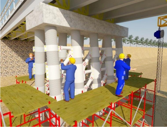
Gambar 5. 18 Pemasangan batang diagonal
