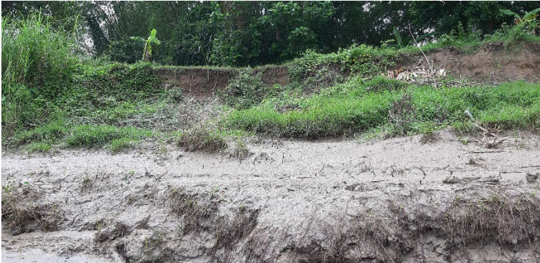
Gambar 1. 7 Tampak depan kondisi tanggul yang mengalami kelongsoran (Sumber: Dokumentasi Pribadi)
