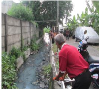
Gambar 4.5 Kondisi Drainase di Desa Wadungasri
