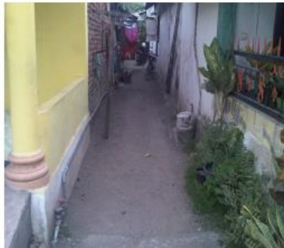
Gambar 4.6 Kondisi Jalan di Desa Wadungasri
