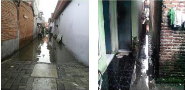
Gambar 4.7 Kondisi Bangunan di Desa Wadungasri
