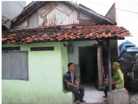
Gambar 4.4 Kondisi Bangunan di Desa Berbek
