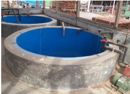
Gambar 2.16 Bangunan Kolam Penampungan (Kolam 1)
