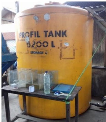
Gambar 2.25 Unit Tandon Akhir
