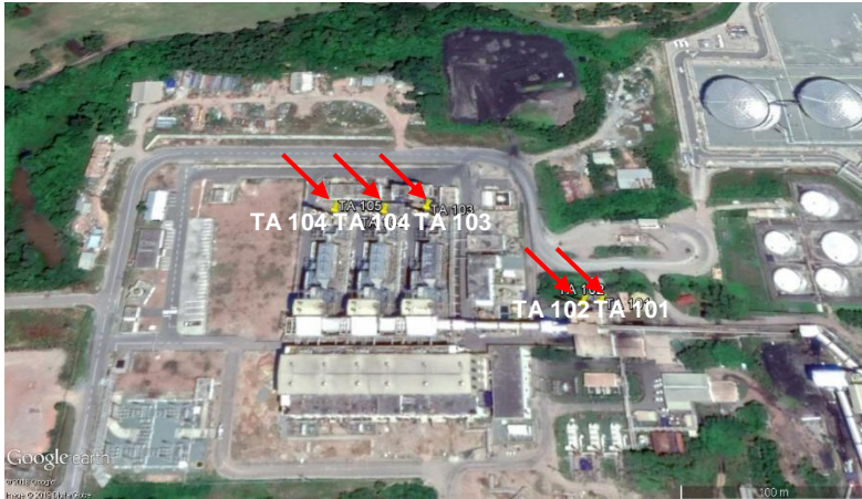
Gambar 4.1 Posisi Cerobong TA 101, TA 102, TA 103, TA 104, dan TA 105
