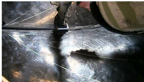
Gambar II. 19 Pengelasan HDPE
