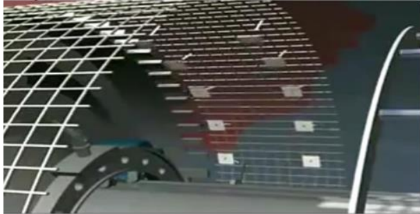
Gambar 5.44 Pemasangan tulangan dan baut batuan Sumber : Cara kerja Tunnel Boring Machine. 2017. < https://www.youtube.com/watch?v=Mx_nGElqiUY&t=26s >
