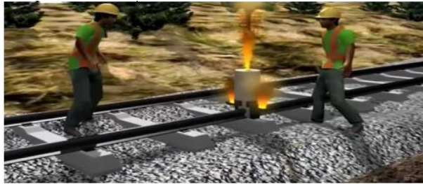
Gambar 5.38 Menyambung dan mengelas rel Sumber : Dirjen Perkeretaapian. 2017. Animasi Kereta Transulawesi makasar – parepare.
