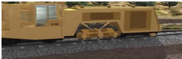
Gambar 5.39 Pemadatan ballas di bantalan beton Sumber : Dirjen Perkeretaapian. 2017. Animasi Kereta Transulawesi makasar – parepare.
