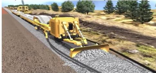
Gambar 5.37 Proses pemasangan bantalan dan rel Sumber : Dirjen Perkeretaapian. 2017. Animasi Kereta Transulawesi makasar – parepare.
