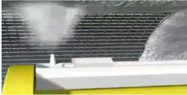
Gambar 5.46 Inject beton cair pada dinding terowongan
