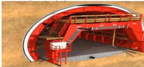
Gambar 5.47 Cor lantai kerja dan penghalusan dinding
