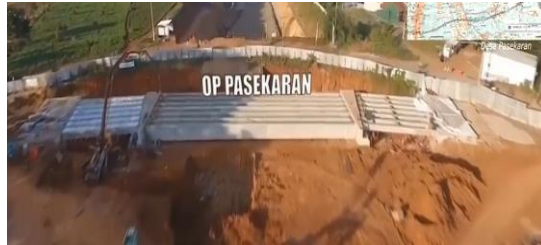
Gambar 2. 2 Pemagaran lokasi proyek (Sumber: PT. Waskita Karya)
