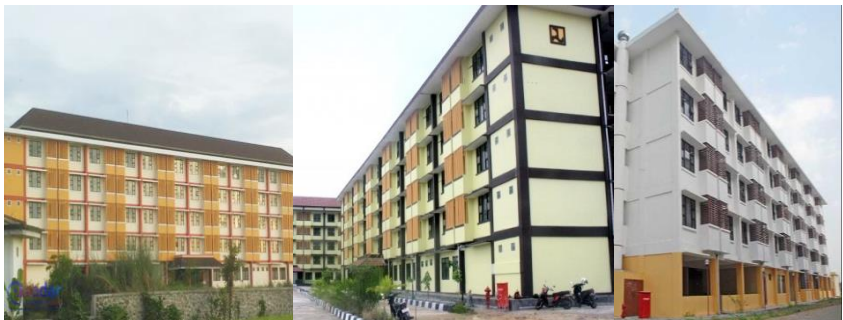
Gambar 4.10 (a) Rusunawa Montong Are. (b) Rusunawa Turida/Mandalika. (c) Rusunawa Selagalas
