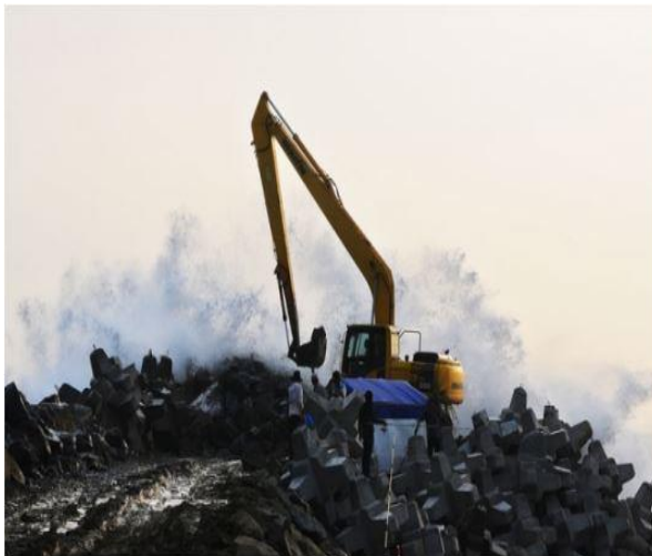
Gambar 2. 8 Pembangunan PPI Logending (sumber : info kebumen, 04/16)
