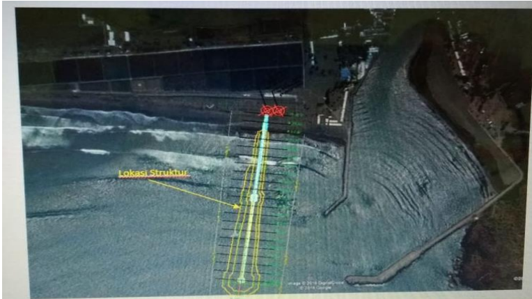
Gambar 2. 2 Tampak Atas Bangunan Groin (sumber : Dok. WIKA)
