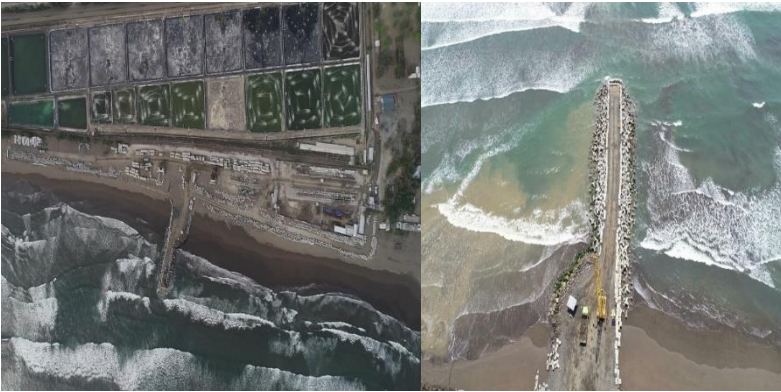
Gambar 2. 1 Proyek Pembangunan Groin di Pantai Jetis (sumber : Dok. WIKA)
