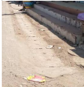
Saluran Drainase Tertutup
