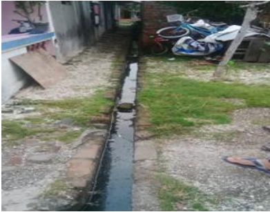
Saluran Drainase Tersier
