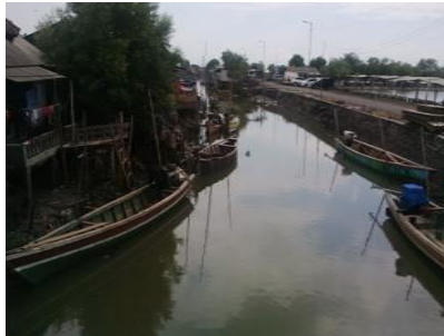
Saluran Drainase Primer
