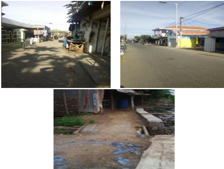
Gambar 4. 8 Kondisi Jalan Lingkungan Permukiman
