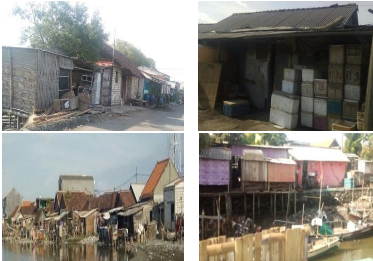
Gambar 4. 3 Kondisi Fisik Bangunan Permukiman
