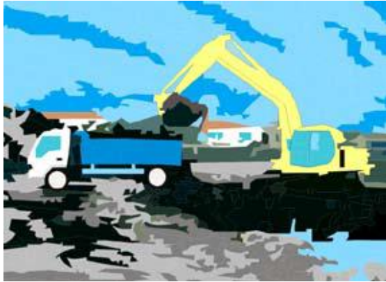
Gambar 6. 4 Memindahkan sedimen dari spoilbank ke dumptruck
