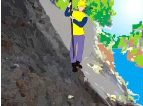
Gambar 6. 9 Pembongkaran pasangan talud yang rusak
