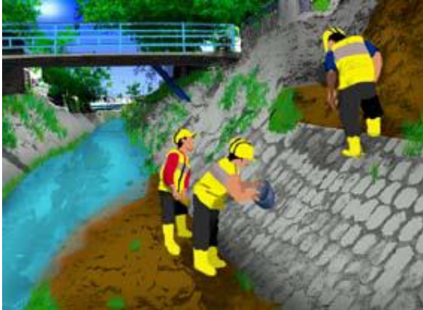
Gambar 6. 13 Pemasangan batu belah dan pasangan dinding
