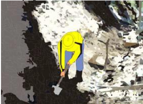
Gambar 6. 12 Gali tanah untuk kepala pondasi
