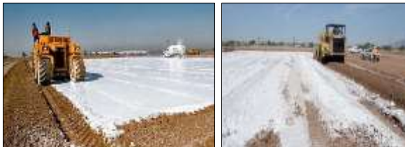
Gambar 1. 6 Proses stabilisasi tanah di lapangan dengan menggunakan kapur
