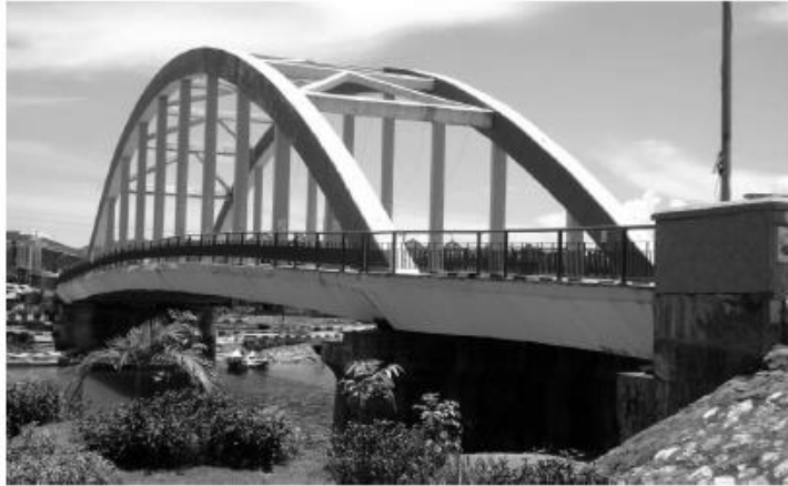
Gambar 2.3 Jembatan Busur Lantai Kendaraan Bawah Sumber: Duan dan Chen.2000. Handbook of International Bridge Engineering
