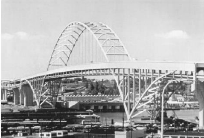
Gambar 2.2 Jembatan Busur Lantai Kendaraan Tengah Sumber: Duan dan Chen. 2000. Handbook of Bridge Engineering
