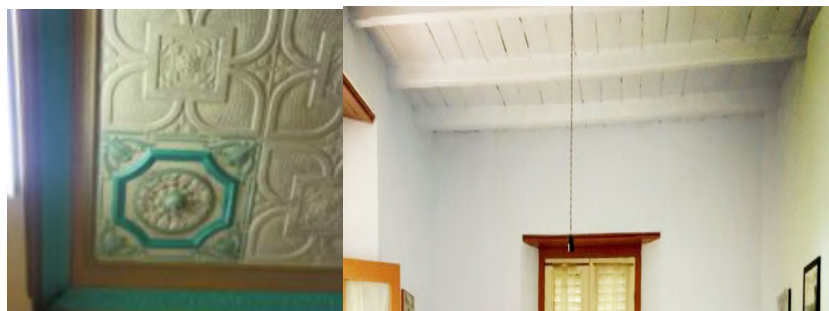
Gambar 2. 13 Plafon Bangunan Kolonial Belanda di Jawa Timur
