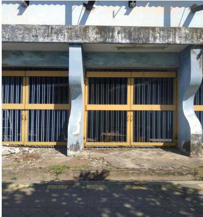
Gambar 5.5 Ruang Generator Pada Galangan Kapal
