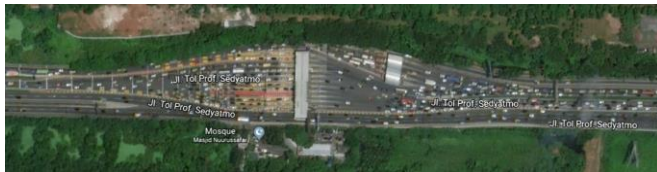
Gambar 1. 2 Gerbang Tol Kapuk (Sumber : Google Earth , 19/11/2018)
