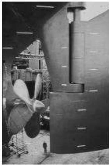
(a) FPP dengan 4 daun propeller yang lebar untuk bulk carrier
