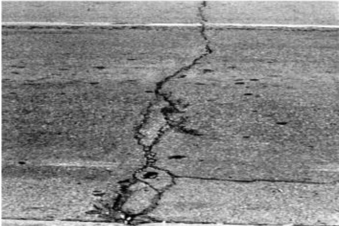
Gambar 2.1 Retak refleksi sambungan
