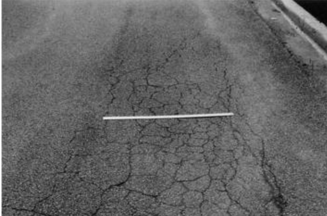
Gambar 2.3 Retak kulit buaya
