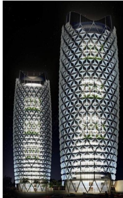
Gambar 2.48 Selubung bangunan sebagai aktifshading device (Cilento, 2012)
