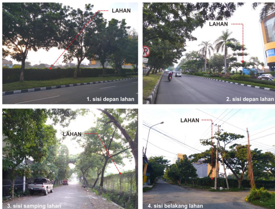
Gambar 4.5 Kondisi eksisting lahan perancangan gedung kantor hemat energi
