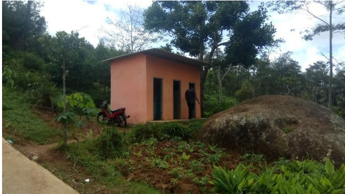
Gambar 4. 11 Kondisi Toilet di Watu Semaur
