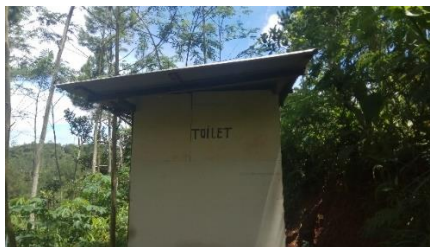
Gambar 4. 17 Kondisi Toilet pada Wisata Tumpak Siman
