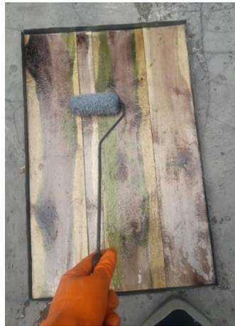
Gambar 3.11 Proses meratakan resin menggunakan *roller*
