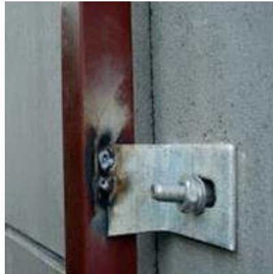
Gambar 5.5 Pemasangan Hollow dan Bracket Menggunakan Dynabolt
