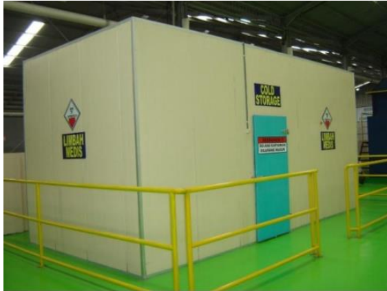
Gambar 2. 3 Contoh Ruang Pendingin Untuk Penyimpanan Limbah B3 Berupa Limbah Infeksius, Benda Tajam, dan/atau Patologis Dalam Waktu Lebih dari 48 (Empat Puluh Delapan) Jam Sejak Limbah B3 Dihasilkan.
