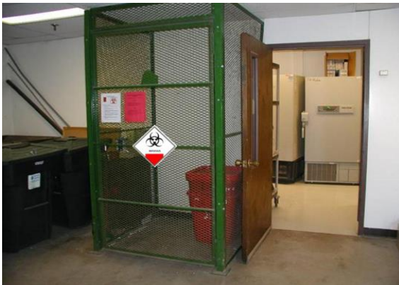
Gambar 2. 2 Contoh Fasilitas Penyimpanan Limbah B3 dari Fasilitas Pelayan Kesehatan Dalam Ruangan yang Dilengkapi dengan Pembatas Akses (Kerangkeng).
