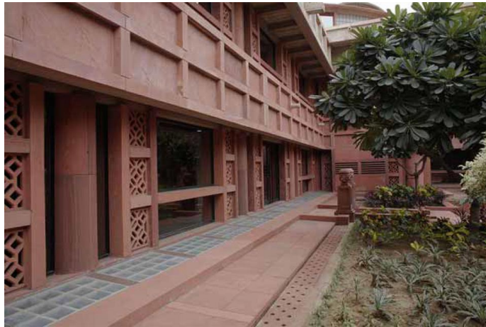
Gambar 2.46 Material dari bata merah pada gedung (Gast, 2007)
