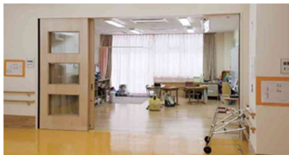
Gambar 2.56 Sliding Door Digunakan untuk Mempermudah Pengguna Kursi Roda Sumber: Jun Ueno (hlm. 6)
