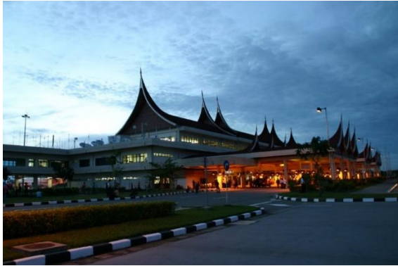
Gambar 1.2. Terminal Bandara Internasional Minangkabau (Sumber: thecolourofindonesia.com diakses pada tanggal 20 November 2018 pukul 08:48 WIB)
