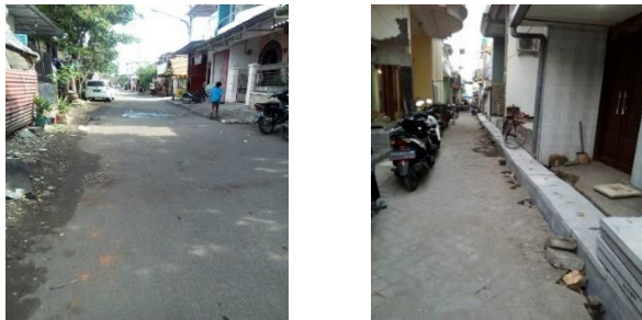
Gambar 4. 13 Badan Jalan Aspal dan Paving RW 07
