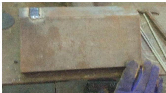
Gambar III.6 Penambalan Pada Daerah Las yang Tidak Rata
