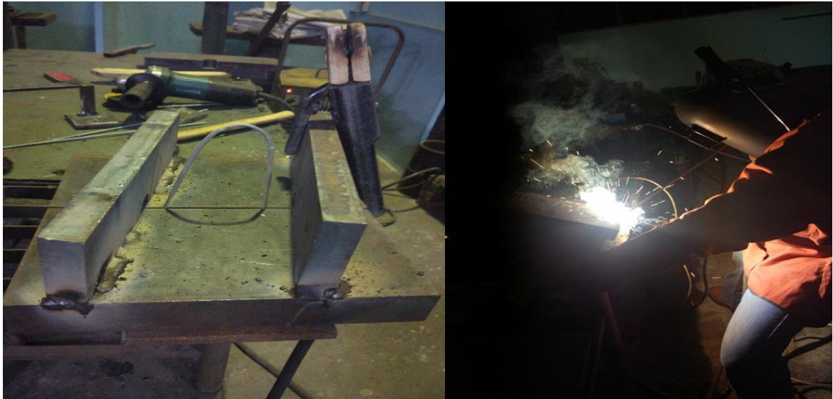
Gambar III.8 Pemasangan Stopper dan Proses Pengelasan
