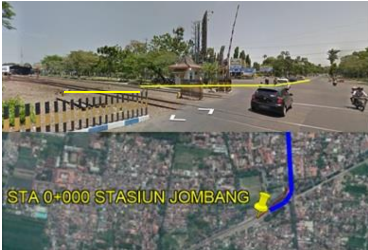
Gambar 4. 4 Emplasemen Stasiun Jombang
