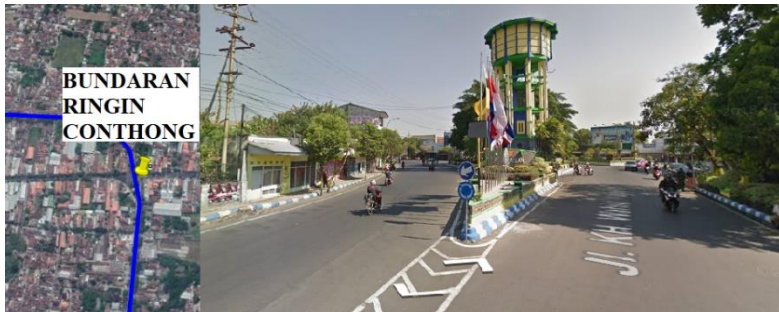
Gambar 4. 7 Dokumentasi Tandon Air
