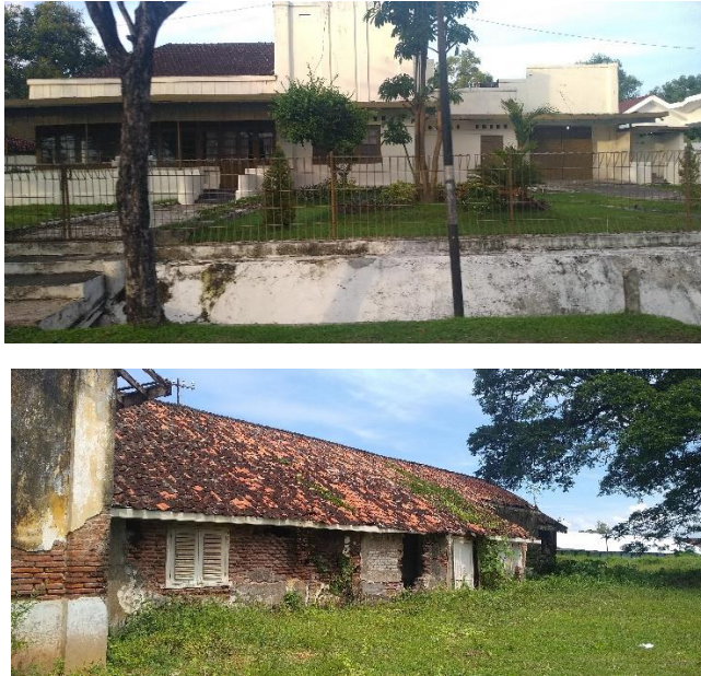
Gambar 4. 11 Kondisi eksisting bangunan Kota Tua Kalianget Sumber: Survei Primer, 2019
