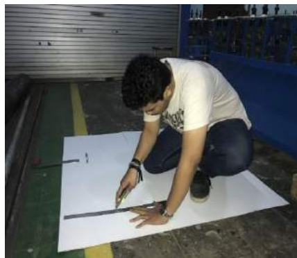
Gambar 3.6 Pembuatan Cetakan 50 cm x 50 cm menggunakan triplek melamin
