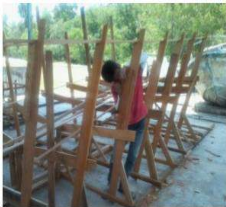
Gambar 2.16 Pemasangan frame [sumber: Ardiana, Razali, Muharnis, 2014]
