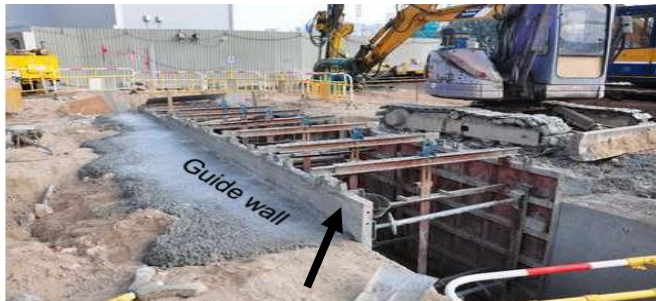
Gambar 6.1. Konstruksi Guide Wall Sumber : Google Images
