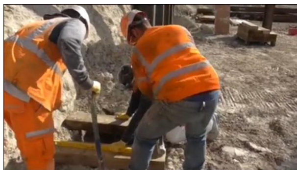
Gambar 6.11. Pemasangan Bracing Pada Lubang Kingpost (Lapangan) Sumber : Google Images
