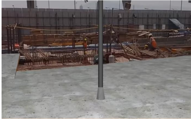
Gambar 6.22. Ilustrasi Pekerjaan Pengecoran Plat Sumber : Google Images
