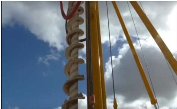
Gambar 6.8. Pengeboran Tanah Menggunakan Auger
