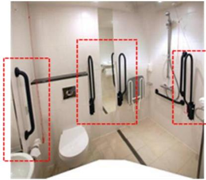
**Gambar 2. 61** Penempatan Pegangan atau *Handrail* pada Kamar Mandi
