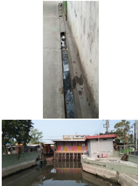
Gambar 4. 2 Jaringan Drainase pada Kelurahan Kalisari Sumber: survey primer, 2019
