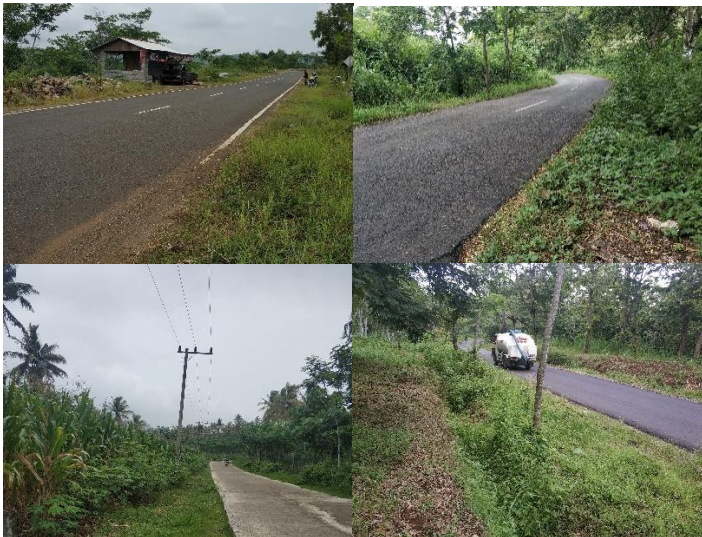
Gambar 4.1 Kondisi Jalan di Beberapa Kecamatan di Tulungagung
