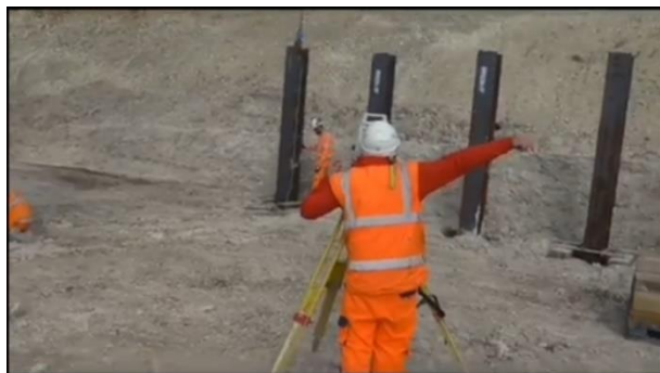
Gambar 6.13. Pengecekan Ketegakan Kingpost Sumber : Google Images
