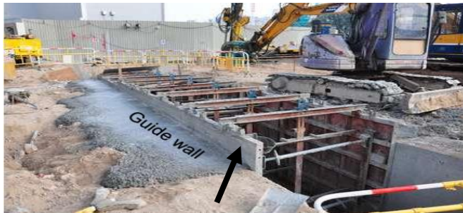
Gambar 6.1. Konstruksi Guide Wall Sumber : Google Images
