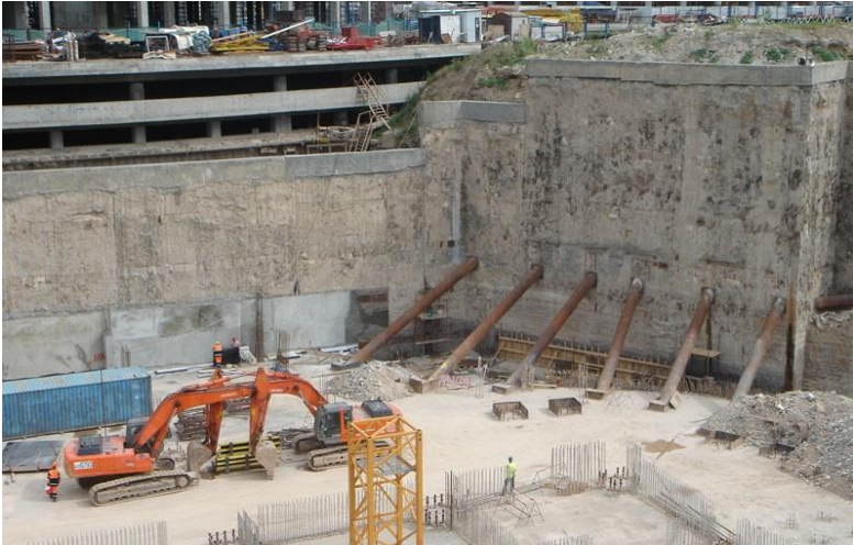
Gambar 2.24. Konstruksi diaphragm wall (sumber : Google Images)
