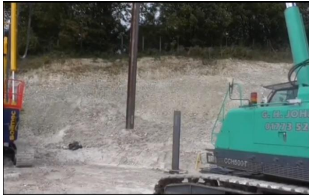
Gambar 6.12. Proses Pengangkatan Kingpost Sumber : Google Images
