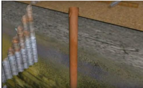
Gambar 6.9. Pemasangan Casing
