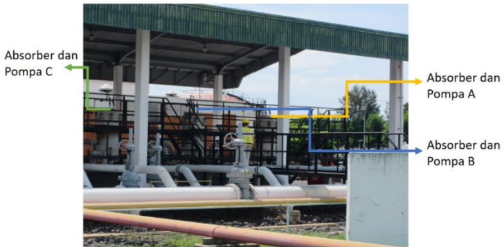
Gambar 3.2 pipeline dan absorber A, B, dan C
