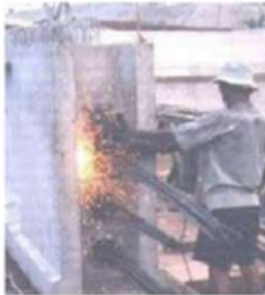
Gambar 2.18 Pemotongan strand
