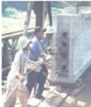
Gambar 2.15 Pemasangan kabel strand
