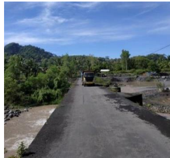
Gambar IV. 64 Jembatan Menuju Pantai Dampar Sumber : Survei Lapangan, 2019
