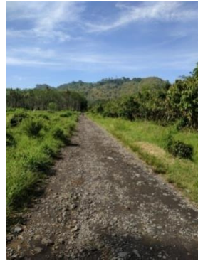
Gambar IV. 66 Jalan Makadam Menuju Dusun Dampar Sumber : Survei Lapangan, 2019
