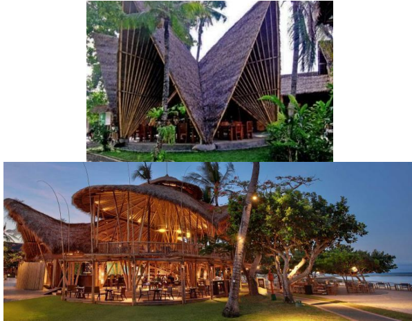
Gambar IV. 103 Bangunan dari Material Kayu, Bambu, dan Daun
