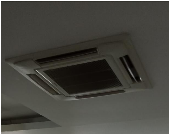
Gambar 4. 24 AC model cassete pada Poli Eksekutif
